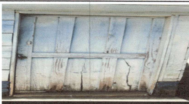
Foto 2: SUSTITUCION DE PUERTA DE METAL
