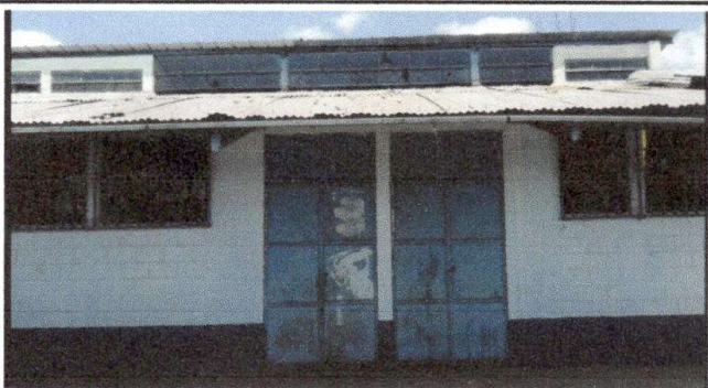
Foto1: CUBIERTA DE LAMINA
