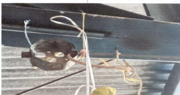
Foto 6: REPARACION DE SISTEMA ELECTRICO
